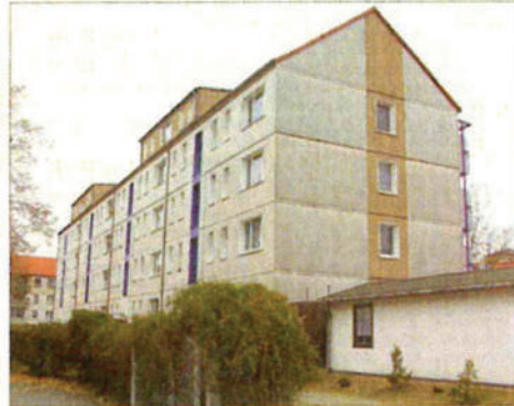
Der Block in der Mühlenstraße hinter den ehemaligen Kaufhallen in Friedland ist für den Abriss im Rahmen der ISEK-Studie im Gespräch. Kurierfoto: ab
