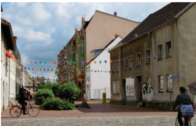
Turmstraße – Baulücke und leer stehendes, unsaniertes Gebäude
