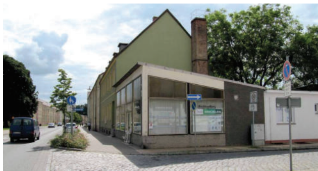
Riemannstraße 21 – städtebaulicher Missstand – Anpassen an die benachbarte Gebäudehöhe und Dachform
