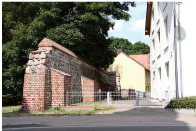
Neue Ringstraße – Öffnung des Teils bis zur Riemannstraße
