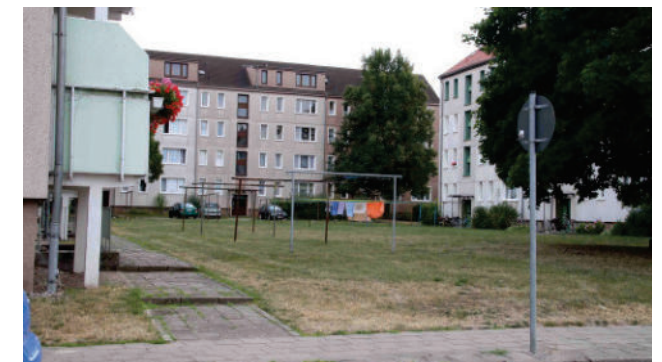
Blick in den Wohnhof Mühlenstraße 44-51
