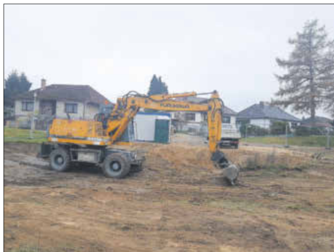
01.12.2020 - Beginn der Erdarbeiten
